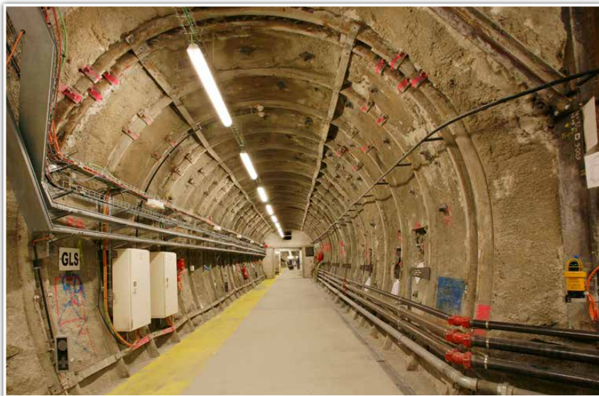
► Galerie du Laboratoire souterrain
