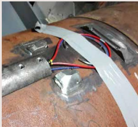
*L'installation de la fibre optique sur le chemisage*
