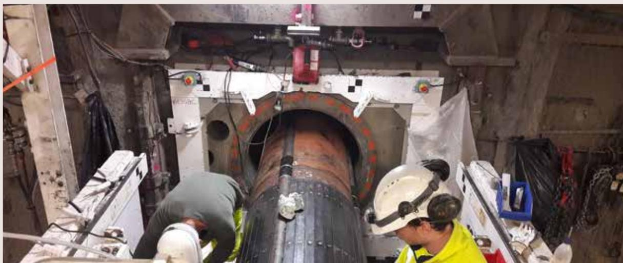
Chemise équipée d'une fibre optique spiralée au moment de la mise en place dans le démonstrateur d'alvéole HA au Laboratoire souterrain
