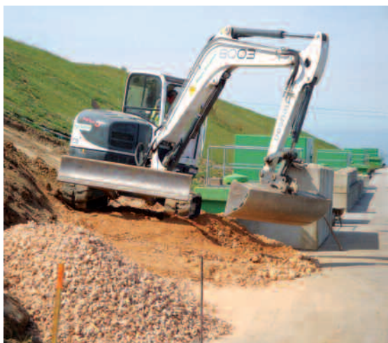
Mise en place des matériaux de comblement sur les pentes des talus.
