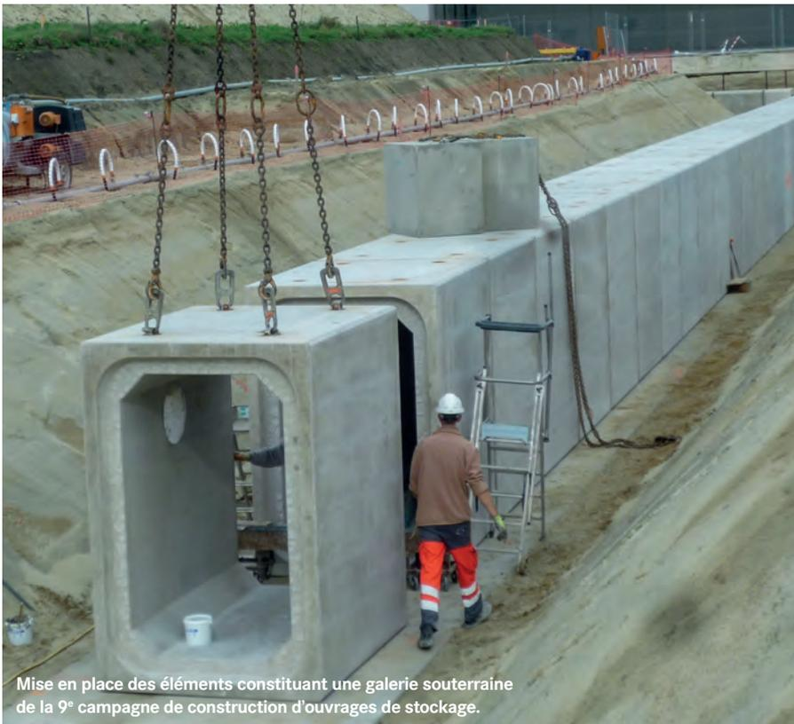
Mise en place des éléments constituant une galerie souterraine de la 9<sup>e</sup> campagne de construction d'ouvrages de stockage.
