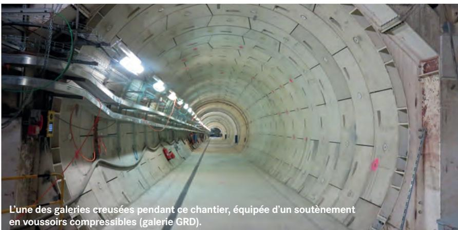
L'une des galeries creusées pendant ce chantier, équipée d'un soutènement en voussoirs compressibles (galerie GRD).
