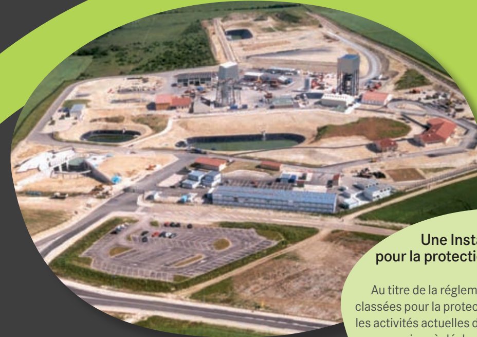
Vue aérienne du site en construction en 2001
