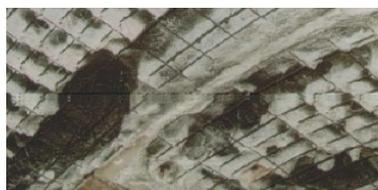
► Béton écaillé après exposition au feu dans le tunnel sous la Manche en 1996 (ferrailage visible après disparition du béton de couverture)
