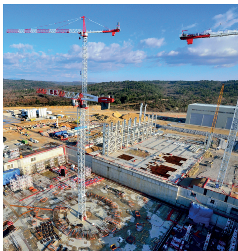
► Chantier de construction d'Iter.
