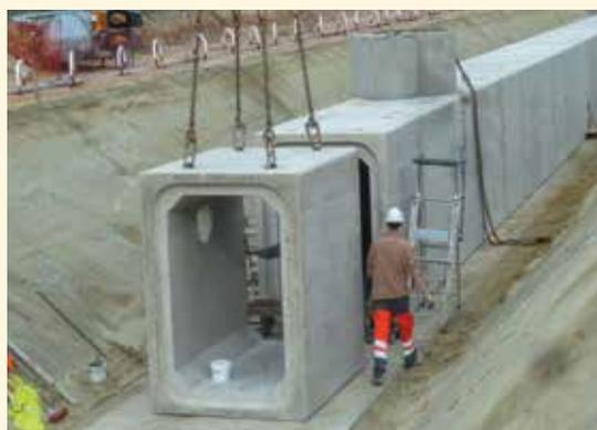
Mise en place des éléments constituant une galerie souterraine lors de la construction d'ouvrages de stockage
