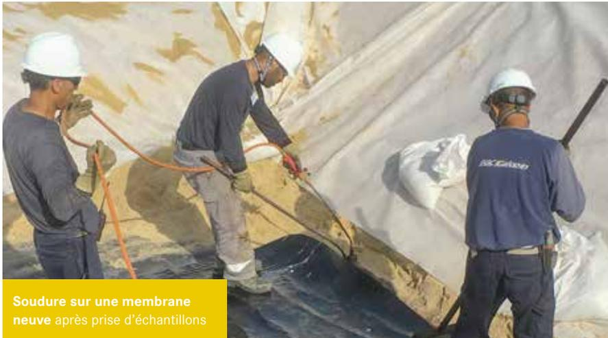
Soudure sur une membrane neuve après prise d'échantillons
