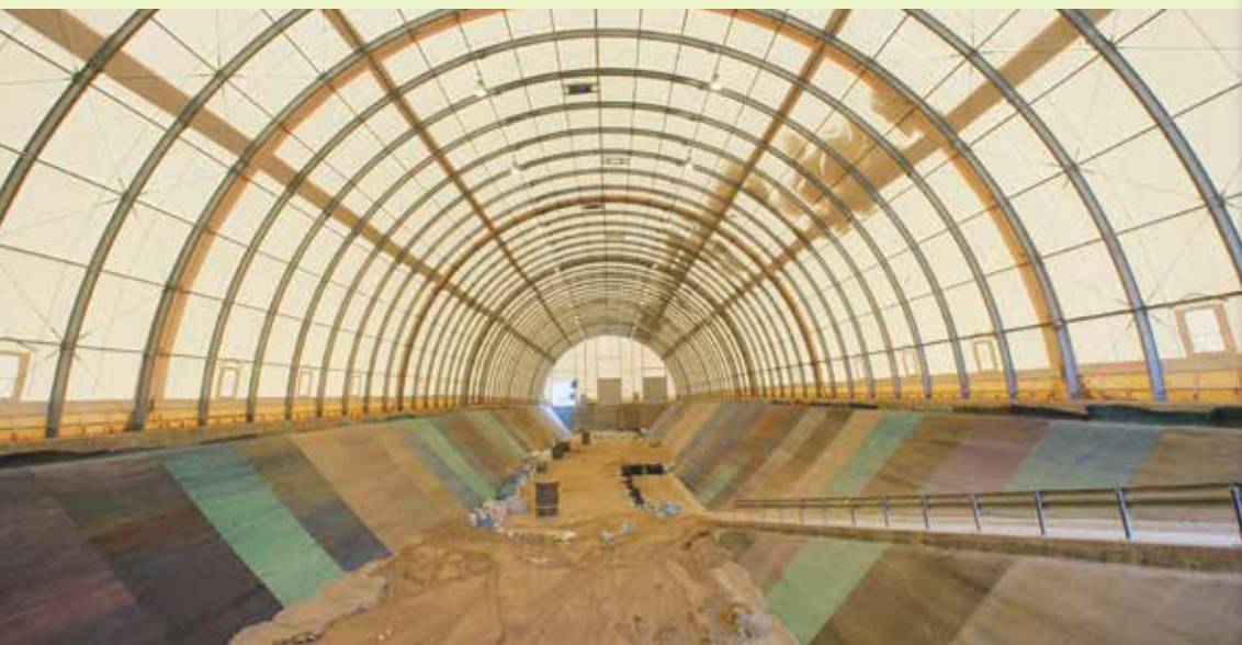
Alvéole de stockage au Cires
