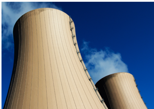
Centrale nucléaire : aéroréfrigérants
