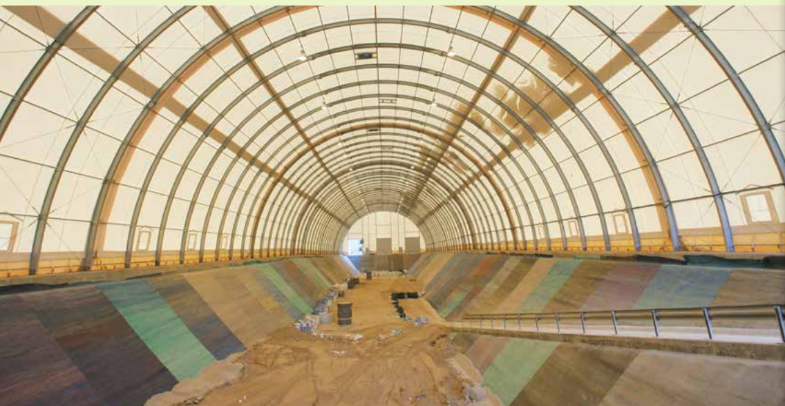
Alvéole de stockage au Cires
