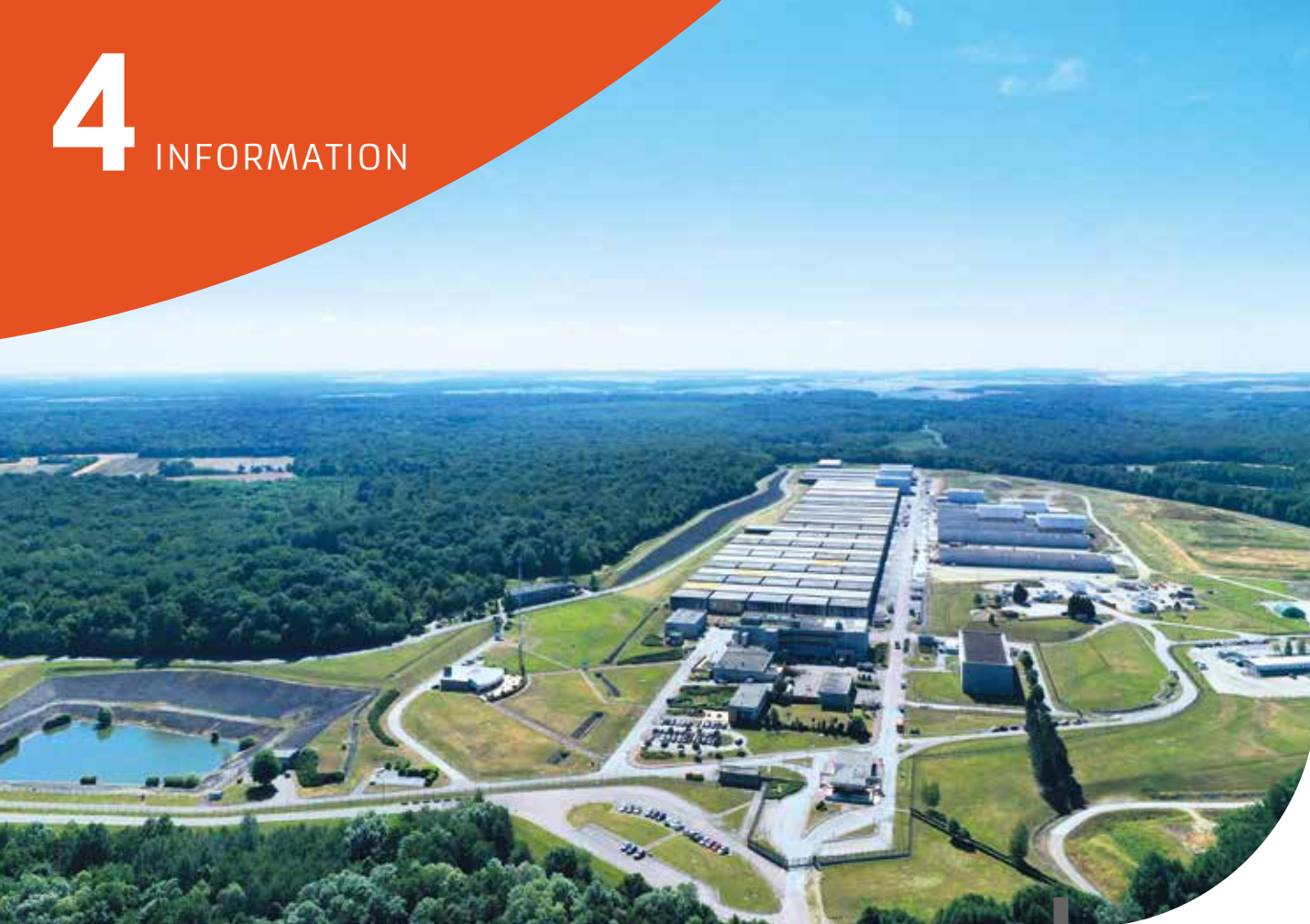
VUE AÉRIENNE du Centre de stockage de l'Aube
