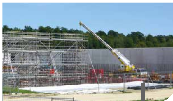
CHANTIER DE CONSTRUCTION de nouveaux ouvrages de stockage
