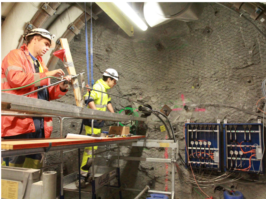
Essai de scellement au Laboratoire souterrain de l'Andra
