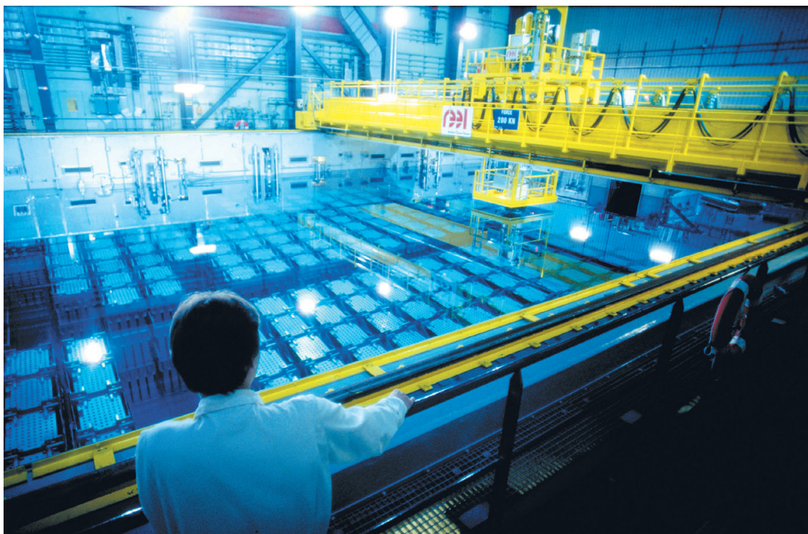
Piscine d'entreposage des combustibles usés à l'usine de retraitement d'Orano à La Hague
