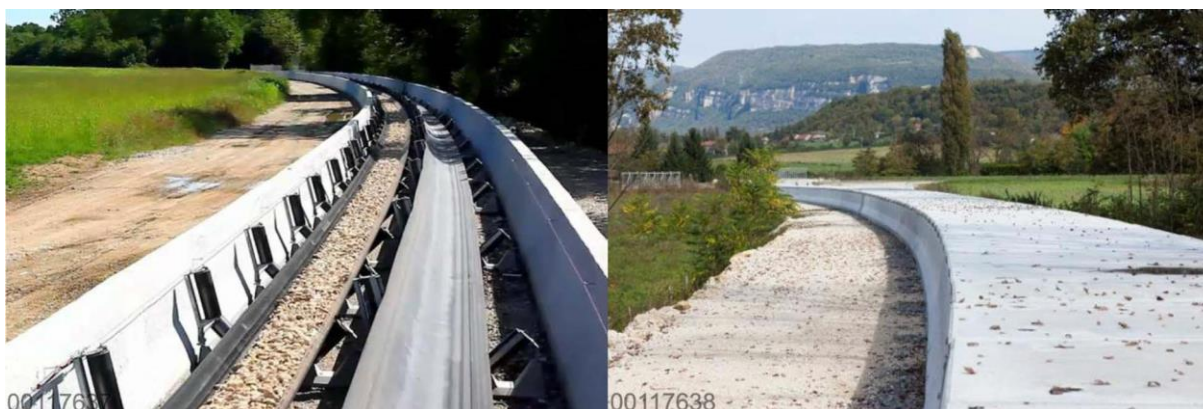
Figure 5-2 Exemple de convoyeur à bande en caisson béton
