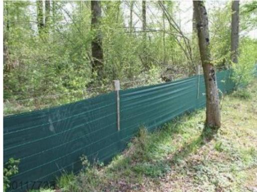
Figure 6-7 Barrière anti-intrusion<sup>23</sup>
