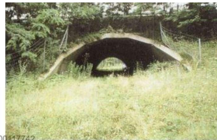
Figure 6-8 Exemple de dispositif de busage pour le passage de la petite faune sous voirie<sup>24</sup>
