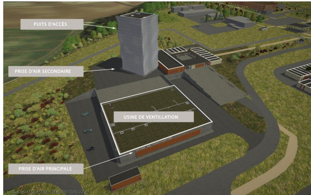
Figure 17-21 Illustration des installations de soufflage d'air frais de la zone puits
