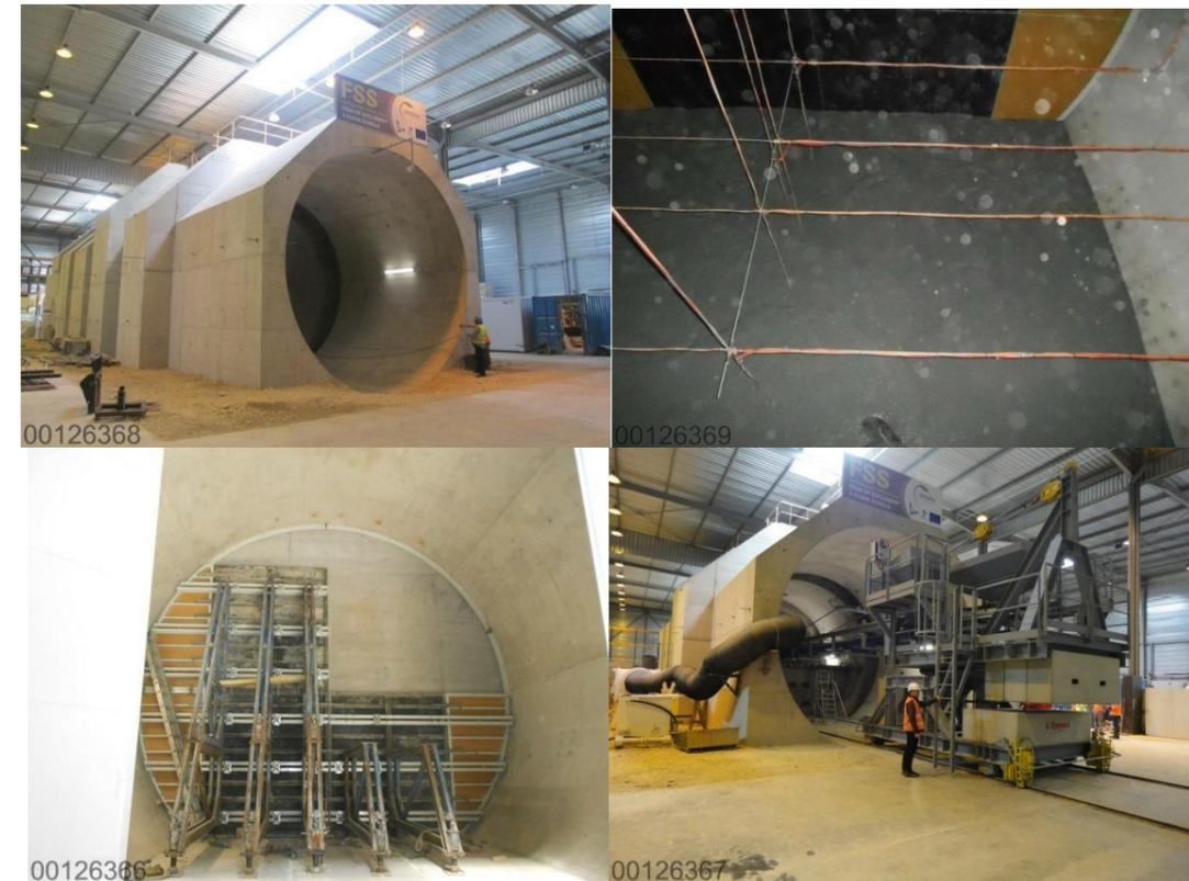
Figure 18-4 Photographies d'essais de réalisation d'un scellement de galerie
