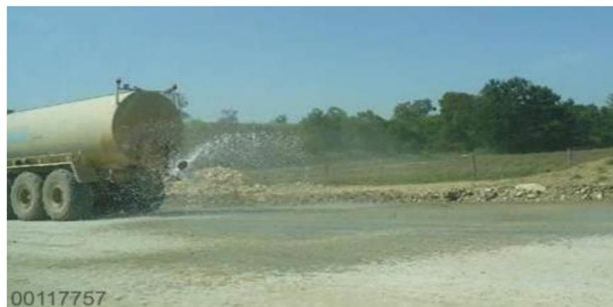
Figure 2-6 Arrosage des pistes pour limiter l'envol de poussières par temps sec
