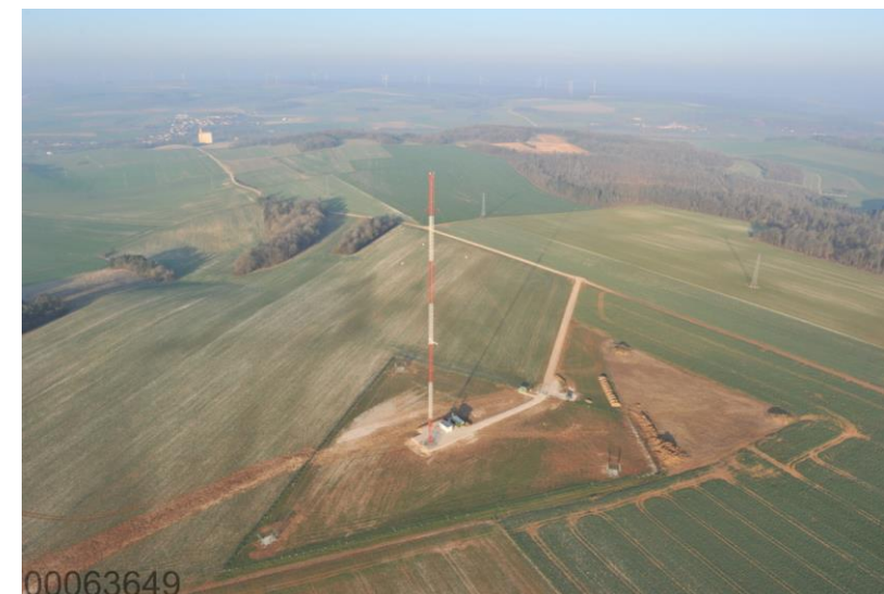
Figure 3-15 Photographie de la station atmosphérique d'Houdelaincourt
