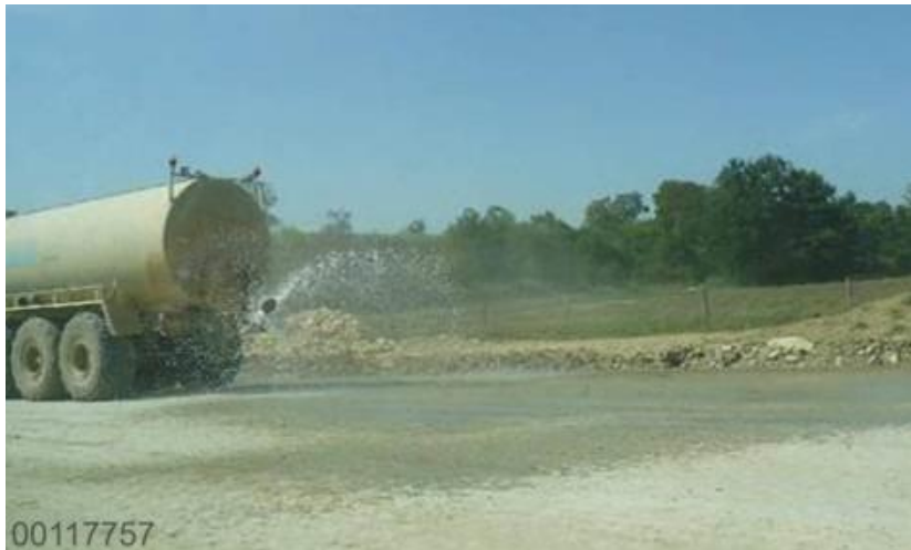
Figure 2-3 Vue de l'arrosage de pistes pour limiter l'envol de poussières par temps sec
