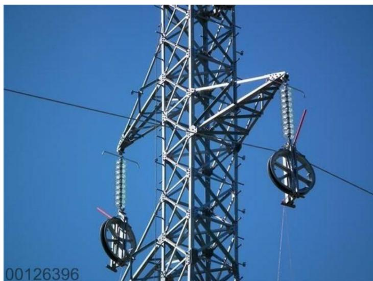
Figure 2-10 Illustration d'une poulie de déroulage (source RTE)
