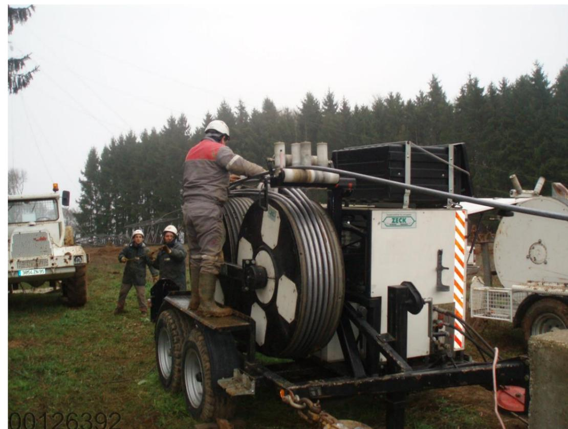
Figure 2-12 Illustration d'une freineuse au niveau du couloir de servitude de la ligne 400 kV (source RTE - juin 2020 (10))
