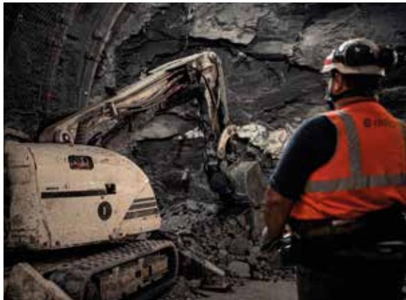
Photographie du déblaiement d'une galerie en cours de creusement au Laboratoire souterrain
