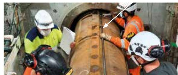
Photographies illustrant la réalisation du démonstrateur d'alvéole de stockage de déchets HA AHA1607 : en haut à gauche, l'intrados de l'alvéole après creusement (trou nu) ; en bas, la pose des tubulures d'inertage/prélèvement de gaz sur le chemisage ; en haut à droite, la pose de l'instrumentation lors de la mise en place du chemisage
