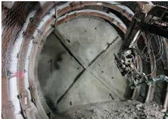
Photographie du bétonnage du front définitif de la galerie GET2 (croix de Saint-André), creusée en préparation des essais de remblaiement de galerie du chantier 4
