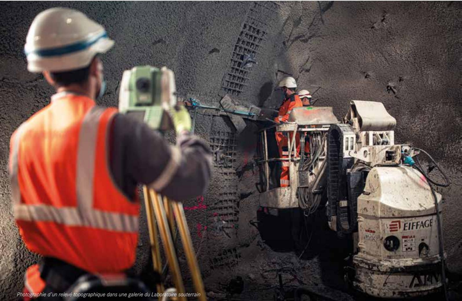
Photographie d'un relevé topographique dans une galerie du Laboratoire souterrain
