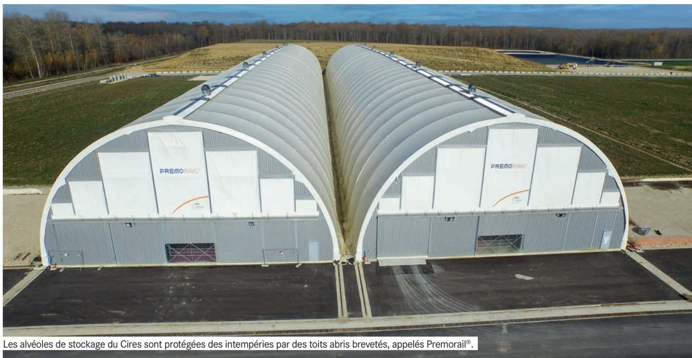
Les alvéoles de stockage du Cires sont protégées des intempéries par des toits abris brevetés, appelés Premorail®.
