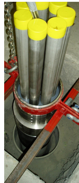
Installation des cannes de support en forage
