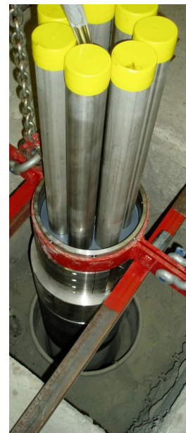
Installation des cannes de support en forage.
