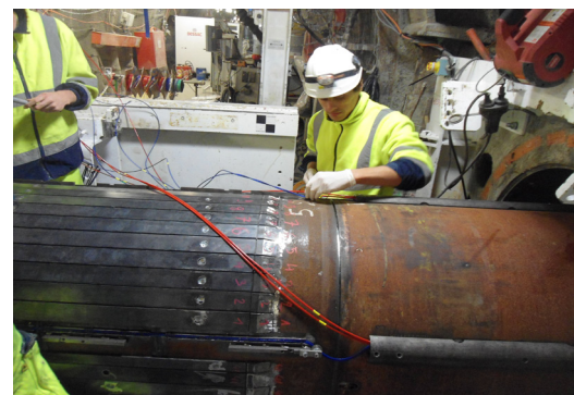
Application du dispositif sur le chemisage en acier d'un alvéole de stockage.
