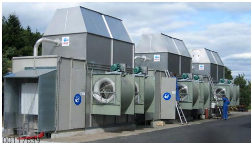
Figure 3-3 Photographie illustrative de refroidisseurs à circuit fermé
