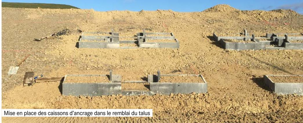
Mise en place des caissons d'ancrage dans le remblai du talus
