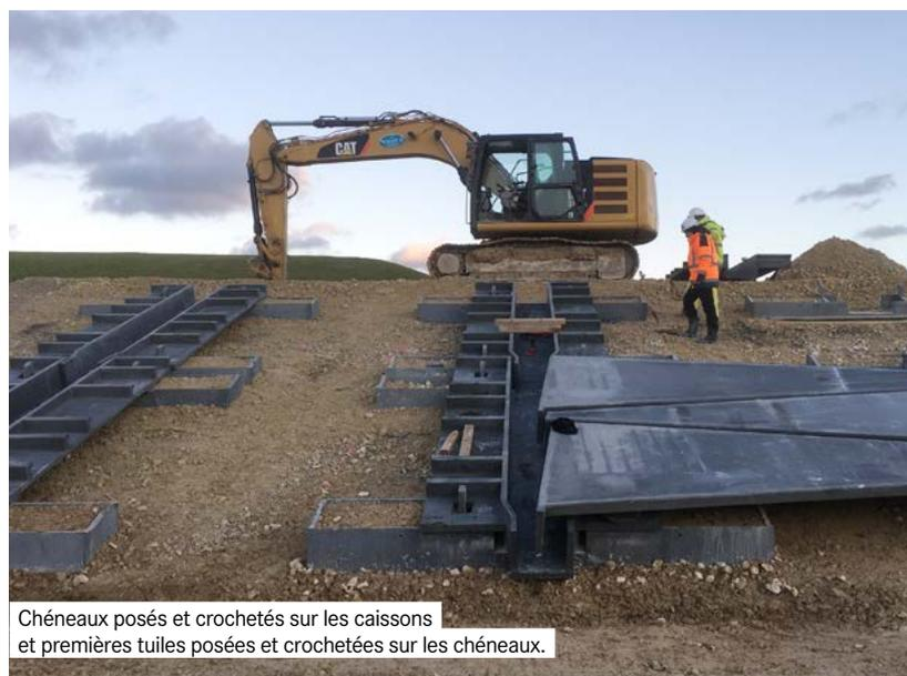
Chéneaux posés et crochetés sur les caissons et premières tuiles posées et crochetées sur les chéneaux.
