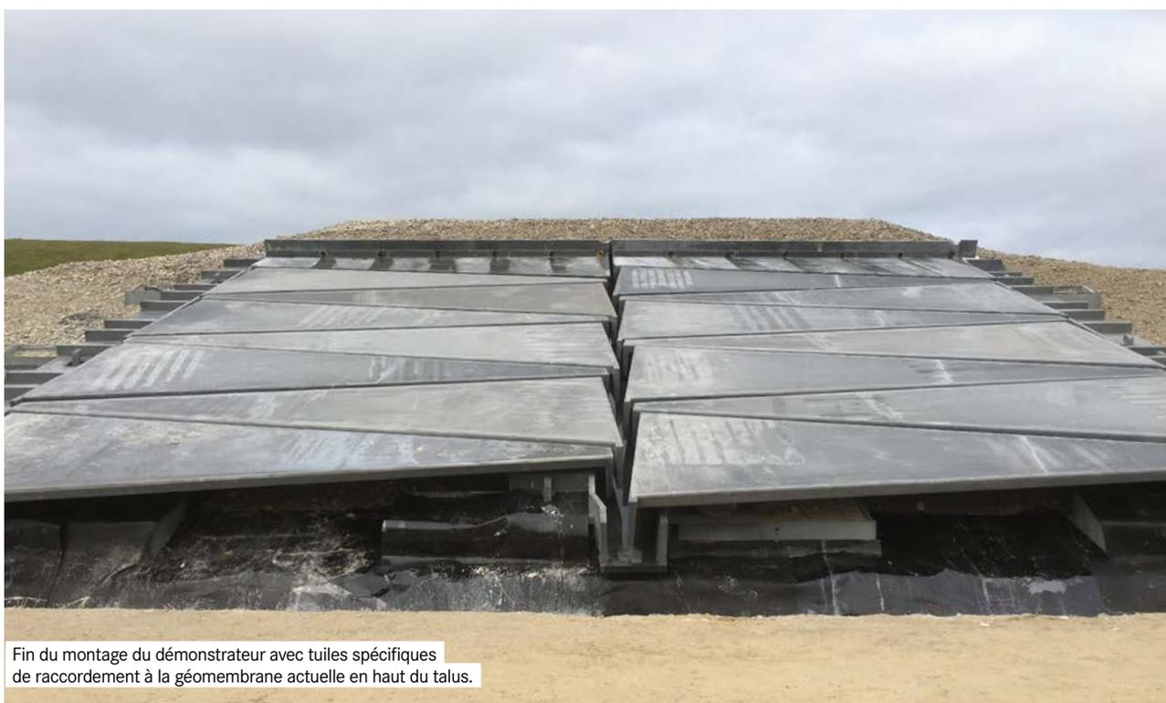
Fin du montage du démonstrateur avec tuiles spécifiques de raccordement à la géomembrane actuelle en haut du talus.
