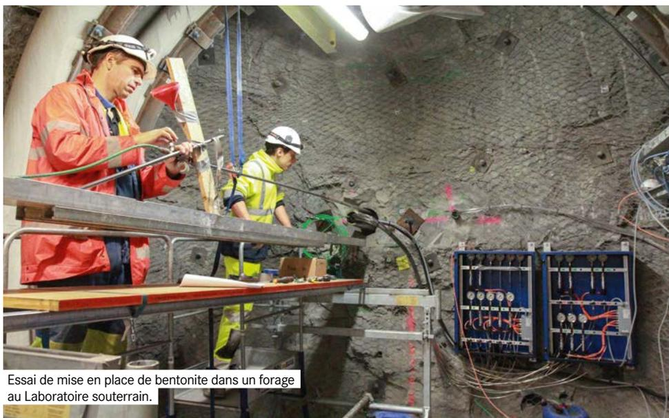
Essai de mise en place de bentonite dans un forage au Laboratoire souterrain.
