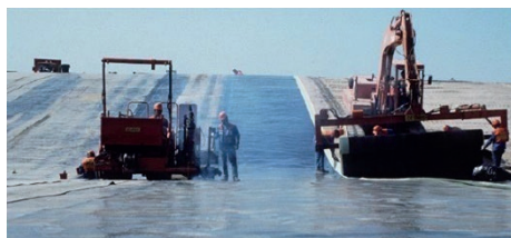
Pose d'une bande de géomembrane. Les bandes sont soudées les unes aux autres.
