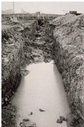
Tranchée ordinaire de stockage (1969)
