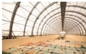
Le Centre de regroupement, d'entreposage et de stockage (Cires)
