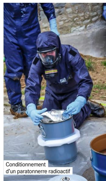
Conditionnement d'un paratonnerre radioactif
