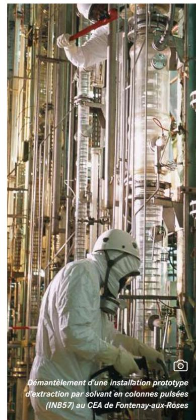
Démantèlement d'une installation prototype d'extraction par solvant en colonnes pulsées (INB57) au CEA de Fontenay-aux-Roses
