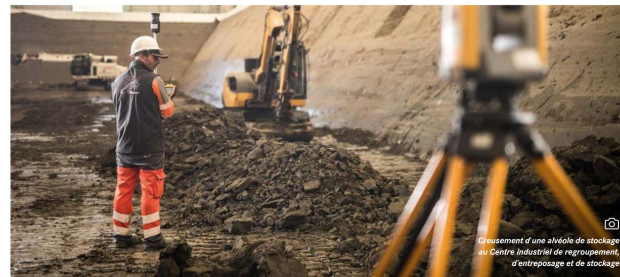
Creusement d'une alvéole de stockage au Centre industriel de regroupement, d'entreposage et de stockage
