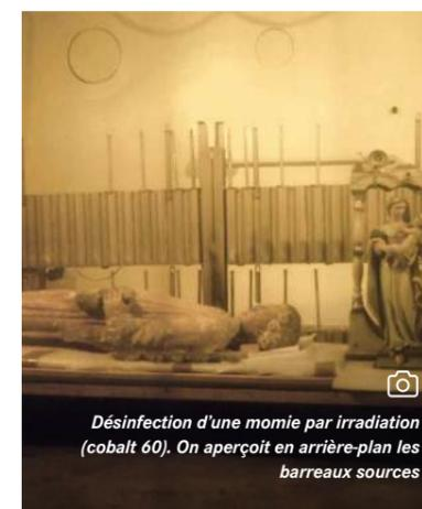
Désinfection d'une momie par irradiation (cobalt 60). On aperçoit en arrière-plan les barreaux sources
