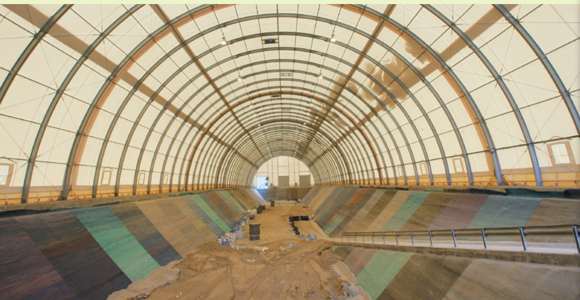
Alvéole de stockage au Cires
