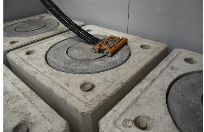
Robot inspectant un colis de stockage en béton
