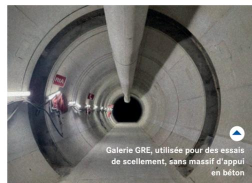
Galerie GRE, utilisée pour des essais de scellement, sans massif d'appui en béton
