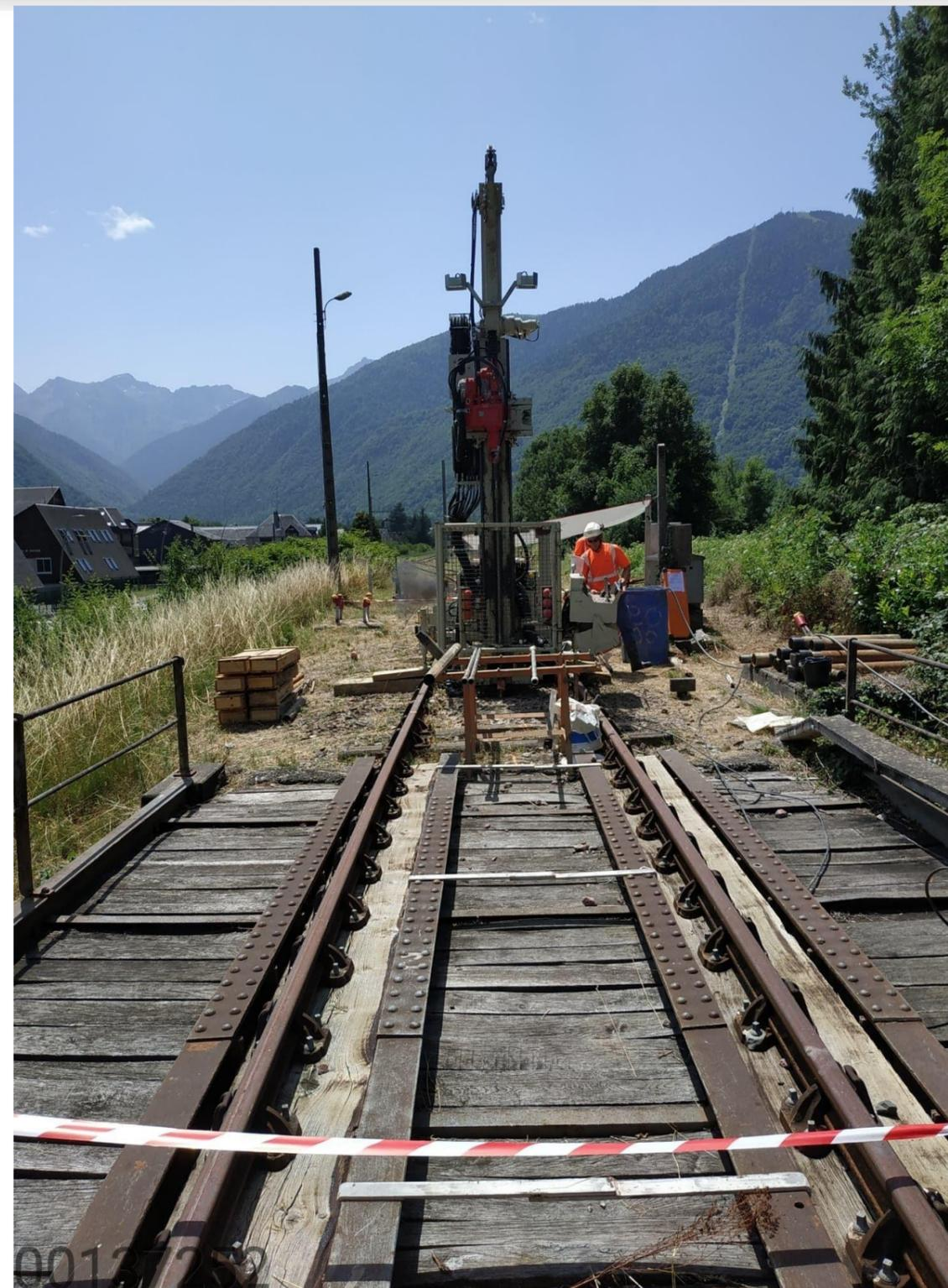
Figure 3-42 Photographie d'un sondage pour essai pressiométrique (Source : Egis, projet Pau-Canfranc)
