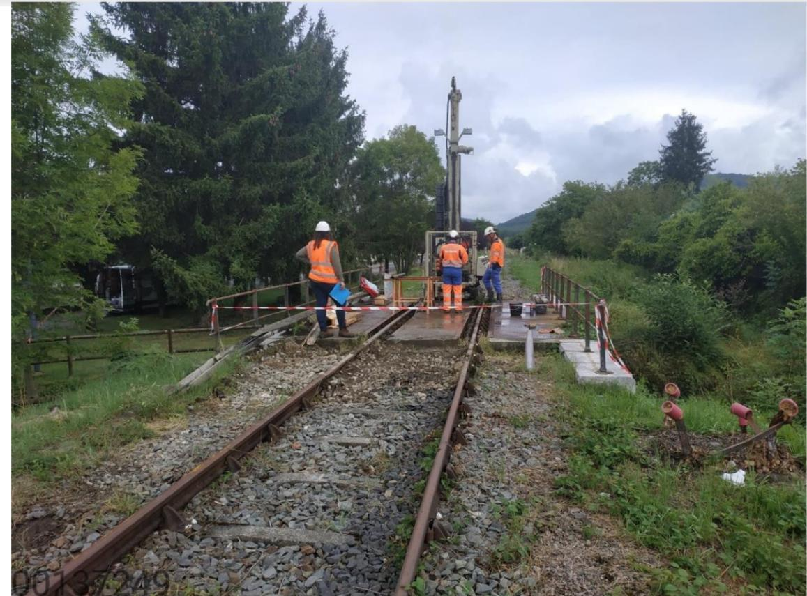
Figure 3-55 Photographie d'un sondage carotté sur ligne ferroviaire
