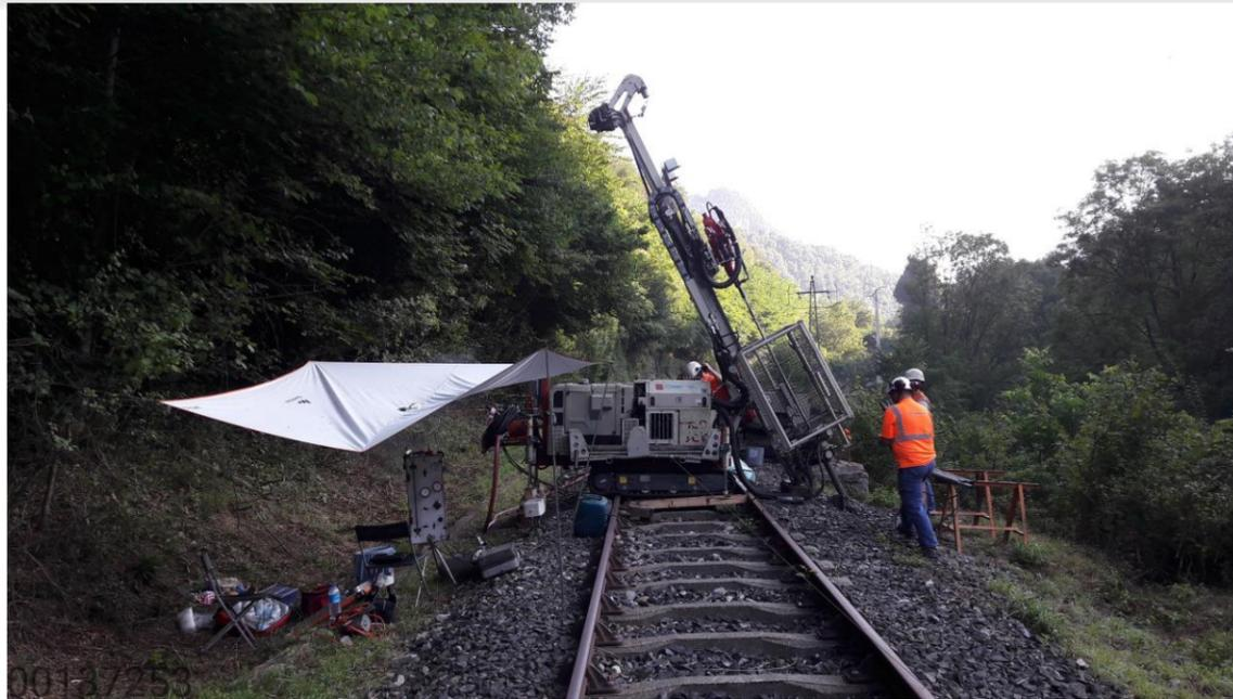
Figure 3-56 Photographie essais piézométrique sur ligne ferroviaire
