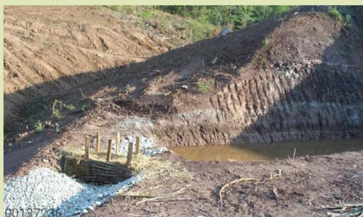
Figure 3-3 Filtre à paille sur chantier
