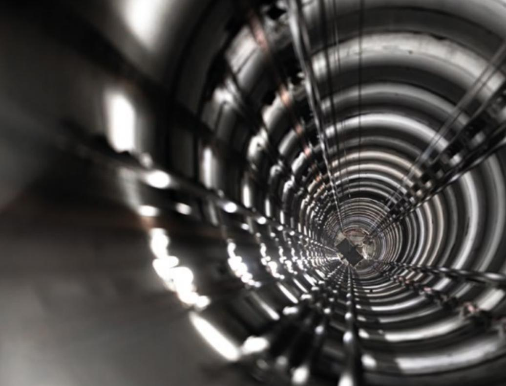
Deux puits de 5 et 6 m de diamètre desservent les galeries expérimentales qui se trouvent à 490 m de profondeur.
