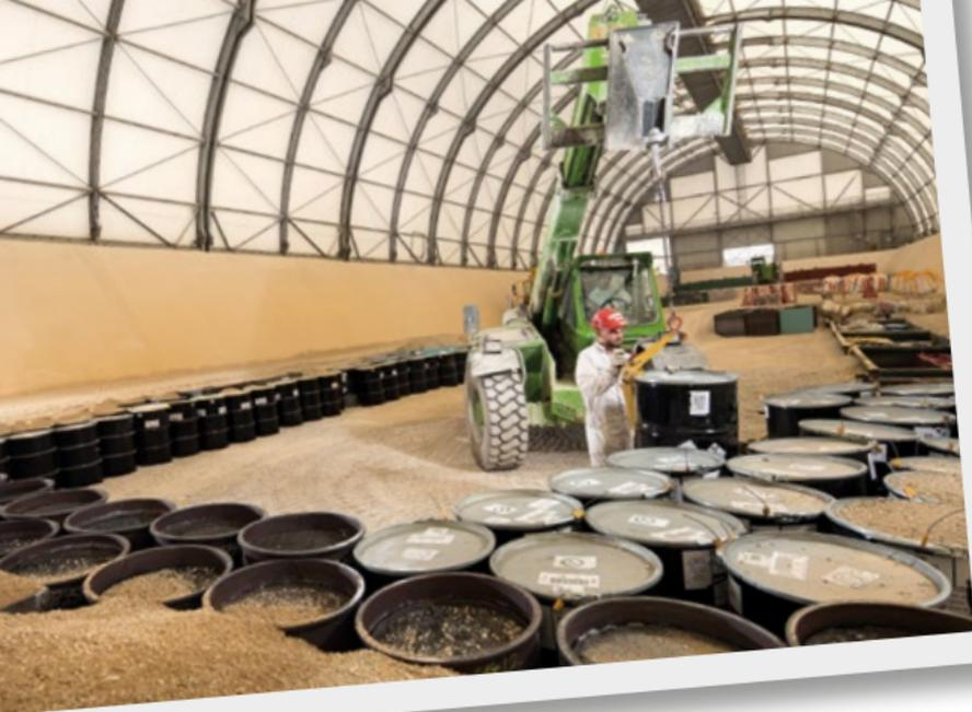
Les alvéoles de stockage sont creusées dans la couche argileuse jusqu'à une profondeur de plus de 8 m. Les colis de déchets y sont ensuite déposés par couches successives.
