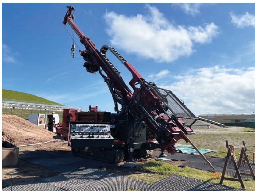
Atelier de forage incliné pour prélèvement d'échantillons de la faille
