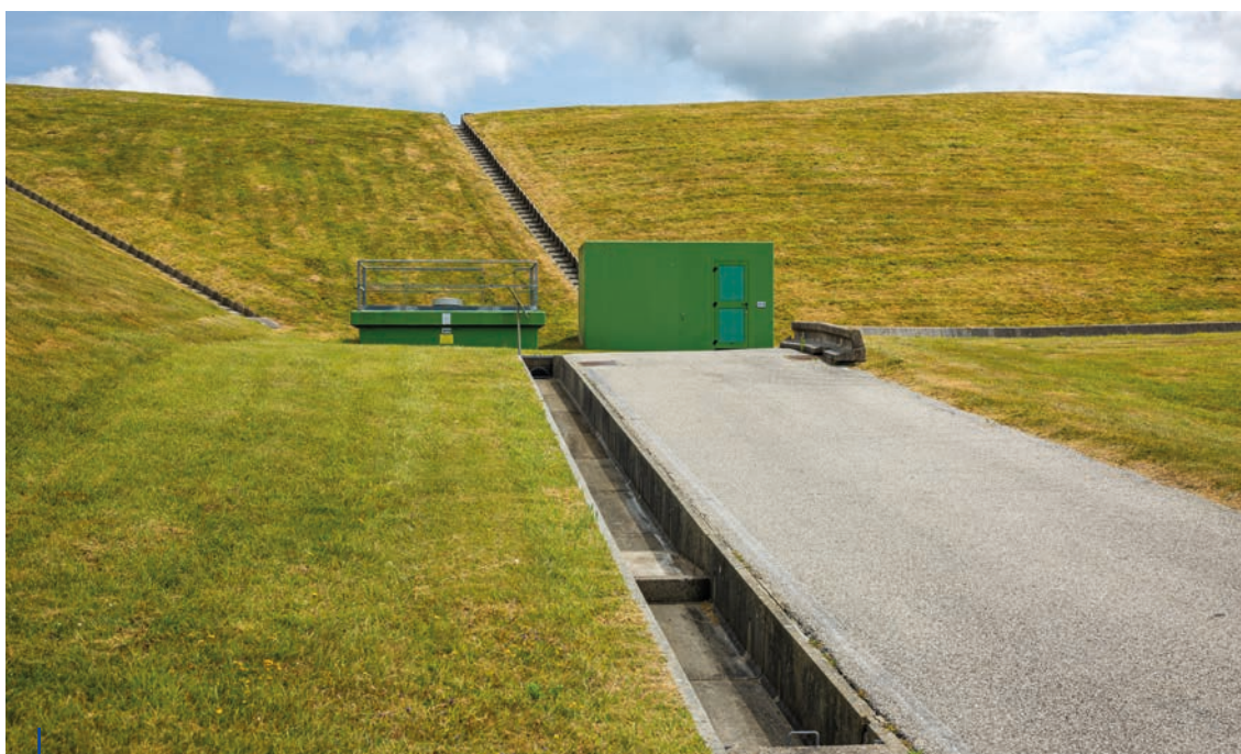
Chambres de collecte des eaux de drainage et pluviales
