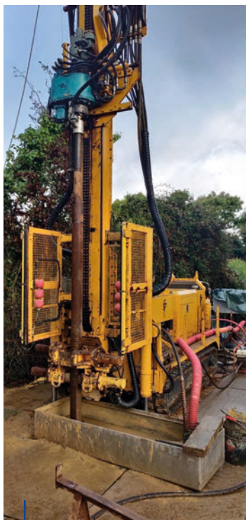
Atelier de forage pour pose de piézomètre
