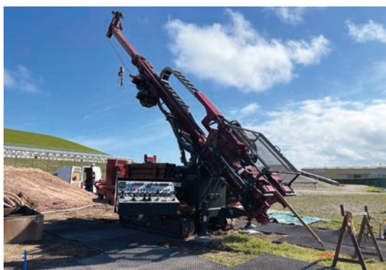
Atelier de forage incliné pour prélèvement d'échantillons de la faille
