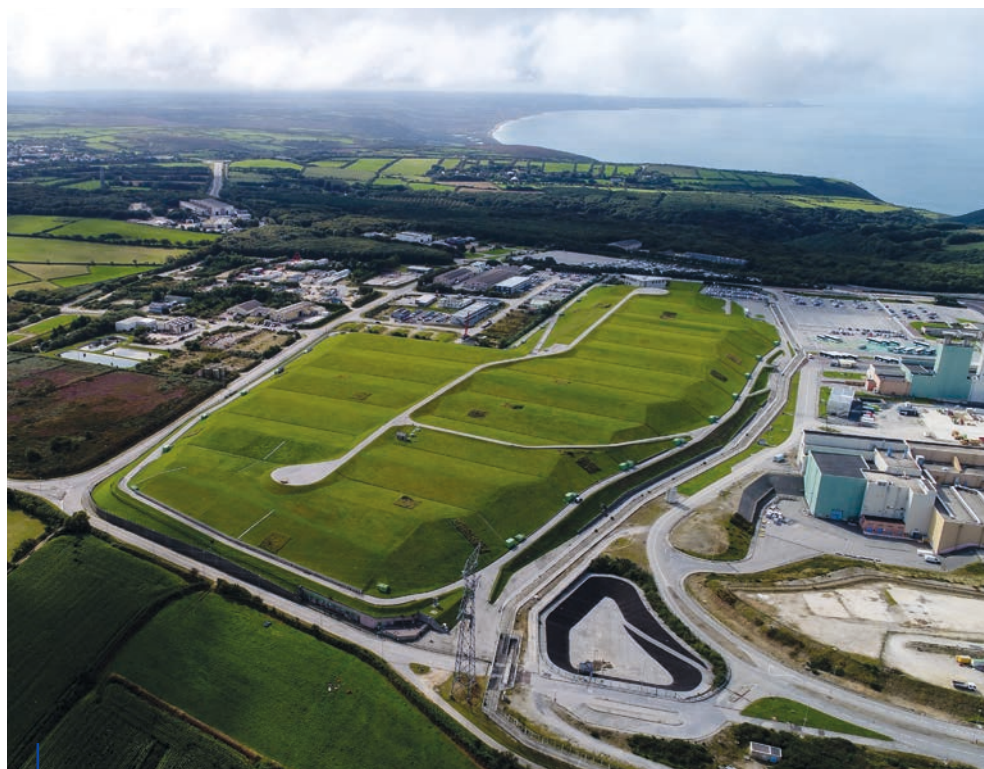
Vue aérienne du CSM
