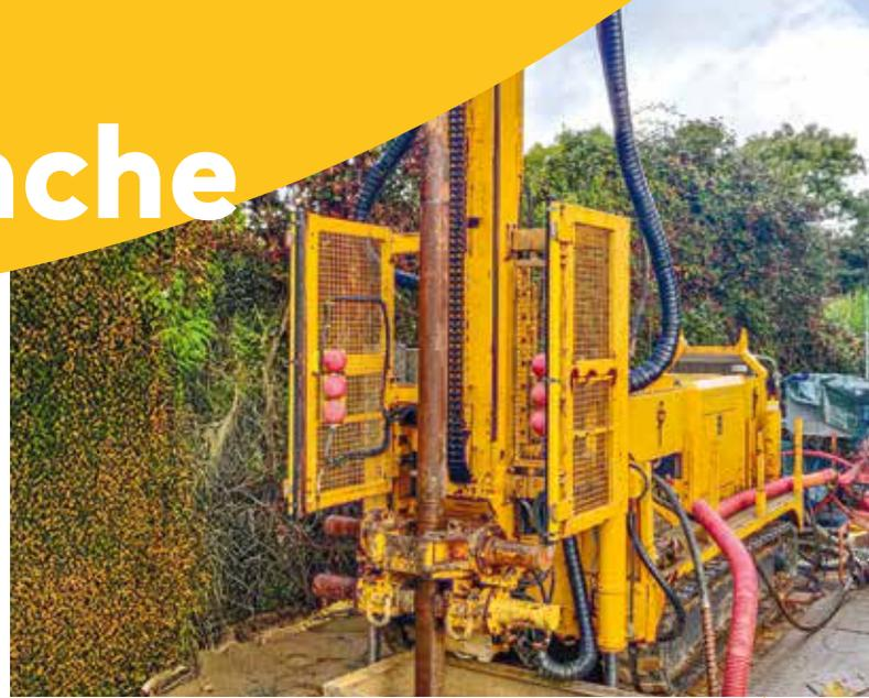
» Atelier de forage pour pose de piézomètre
