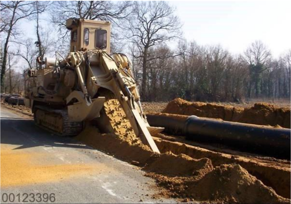
Figure 5-18 Trancheuse pour pose de canalisation
