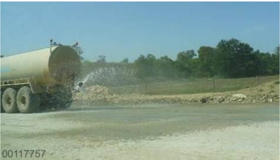
Figure 2-7 Arrosage des pistes pour limiter l'envol de poussières par temps sec
