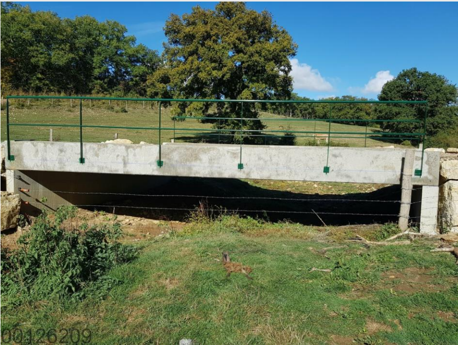
Figure 14-100 Pont aménagé sur l'Ormançon pour faciliter l'accès au bois de la Caisse
