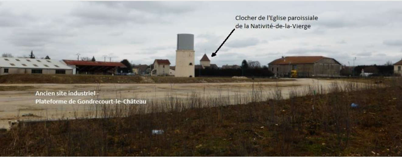
Figure 14-98 Covisibilité actuelle entre l'église de la Nativité-de-la-Vierge (monument historique inscrit) et la plateforme logistique de Gondrecourt-le-Château (source : Systra)
