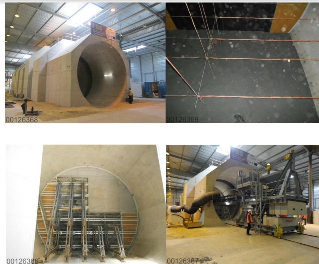
Figure 18-5 Photographies d'essais de réalisation d'un scellement de galerie, notamment FSS (FULL SCALE SEALING) - démonstrateur à caractère technologique en surface à Saint-Dizier (département 52)
