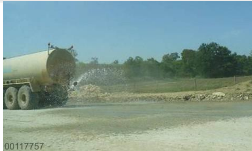
Figure 3-4 Vue de l'arrosage de pistes pour limiter l'envol de poussières par temps sec
