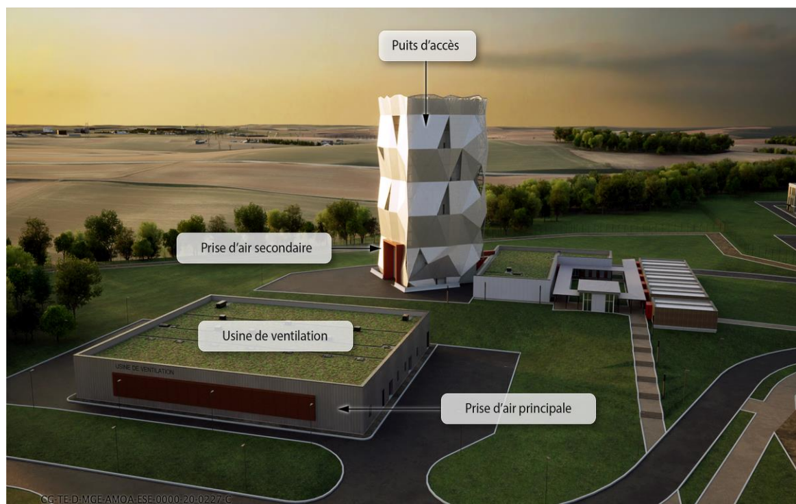
Figure 5-23 Illustration de l'usine de ventilation
