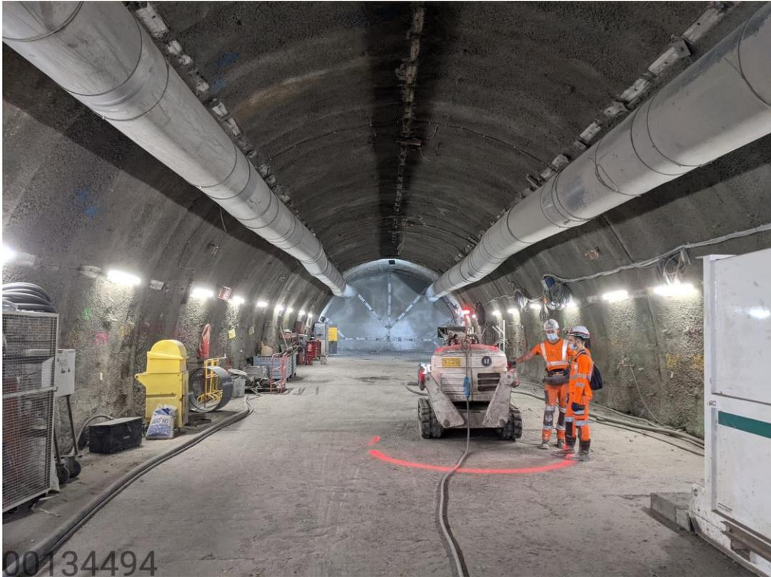
Figure 2-39 Photographie de la demi-section supérieure excavée de l'expérience OMA réalisée dans le Laboratoire de recherche souterrain de Meuse/Haute-Marne
