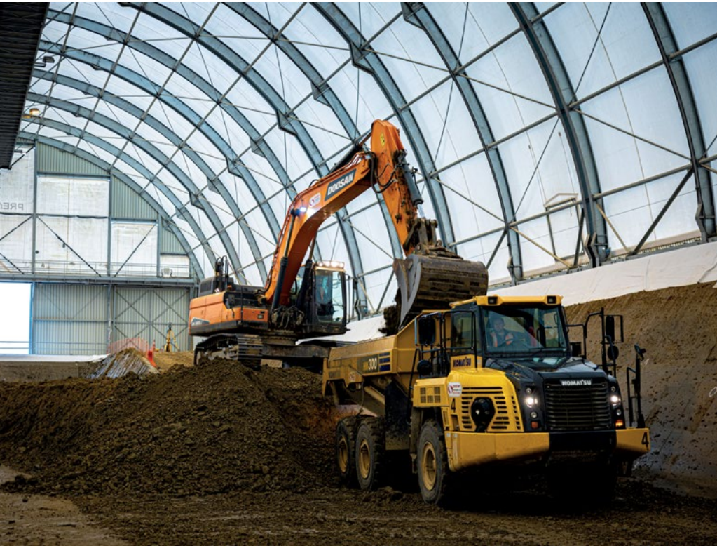
← Creusement d'une alvéole de stockage en surface au Cires
