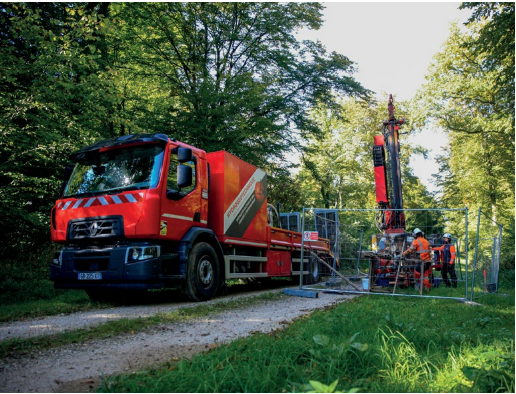
← Opérations de forages géotechniques au bois Lejuc, pour mieux connaître la nature du sol de Cigéo.
