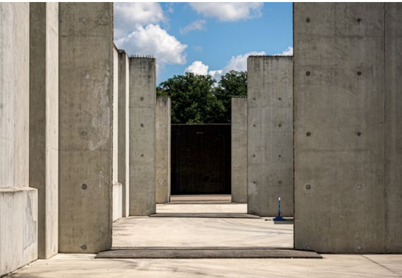
↑ Une nouvelle ligne d'ouvrages de stockages vides, avant exploitation.
