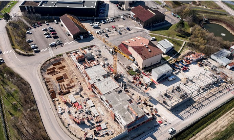
↑ Le chantier de construction du futur cantonnement de gendarmerie, sur le site de l'Andra en Meuse/Haute-Marne.
