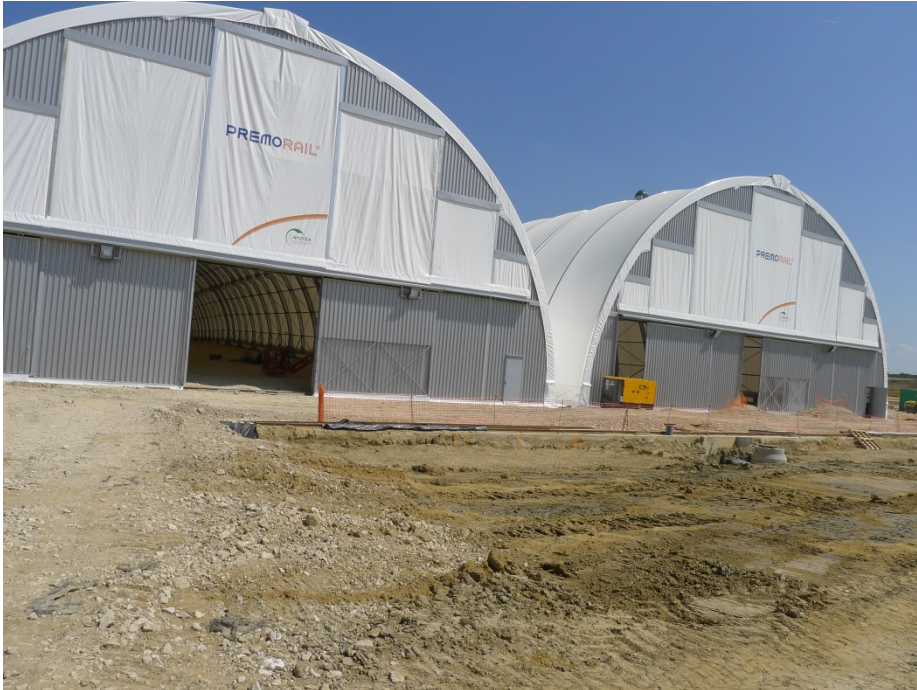
Nouveaux toits-abris Prémorail, vue extérieure
