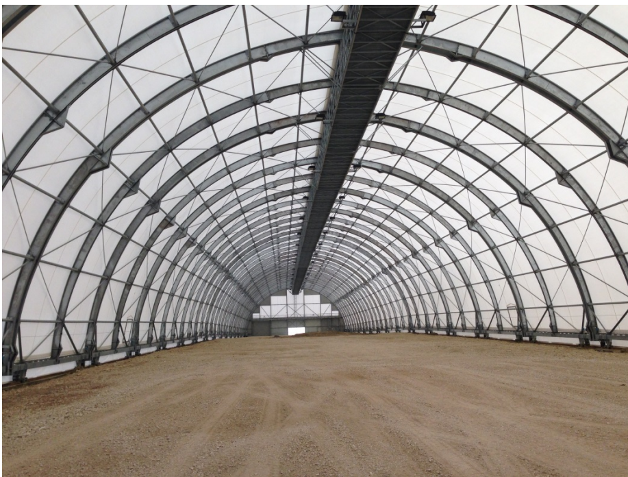
Nouveaux toits-abris Prémorail, vue intérieure
