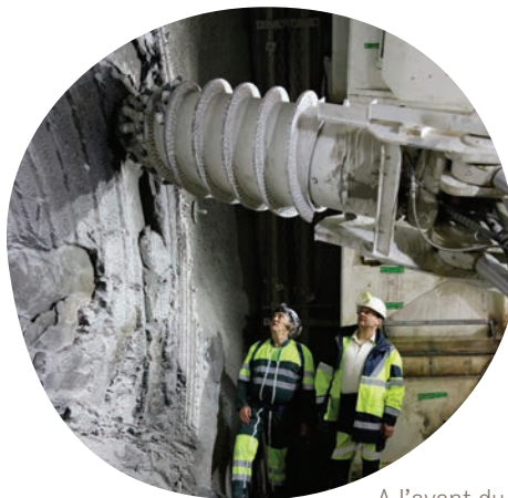
A l'avant du tunnelier, une fraise attaque la roche argileuse.
