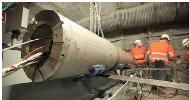
Les colis factices dégagent autant de chaleur que des conteneurs de déchets (HA) grâce à des résistances électriques.
