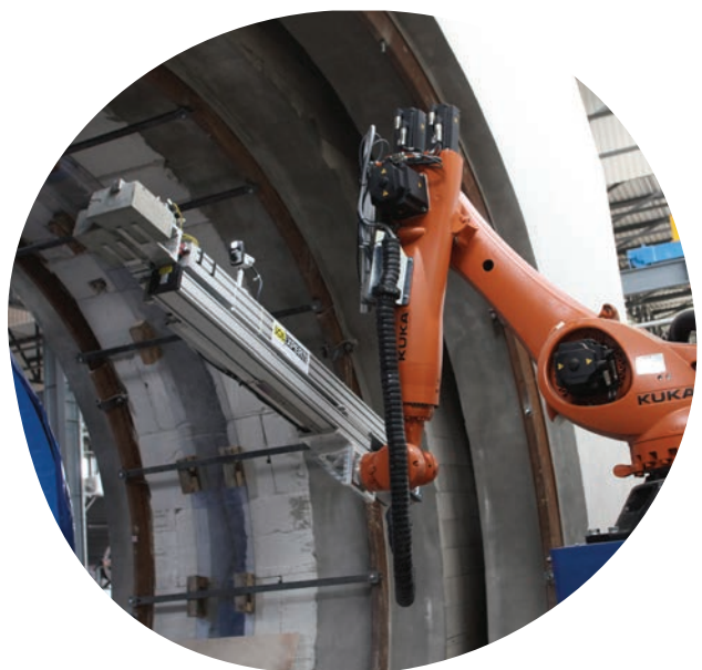
Lors du test, la partie supérieure de la tranchée a d'abord été remplie de briques assemblées par coincement à l'aide d'un robot. La partie inférieure a ensuite été bouchée de billes et de poudre introduites par une vis.
