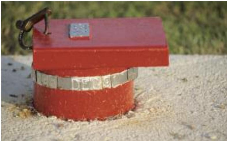
— Le piézomètre permet de vérifier l'absence de contamination radiologique dans la nappe phréatique.
