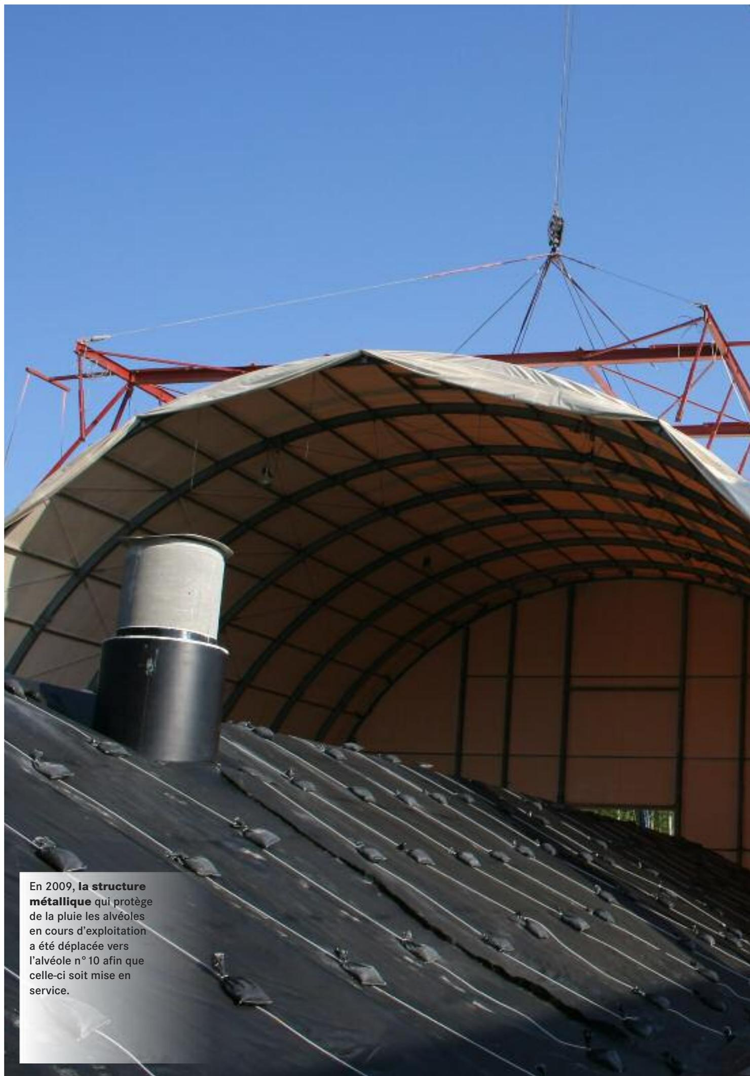
En 2009, la **structure métallique** qui protège de la pluie les alvéoles en cours d'exploitation a été déplacée vers l'alvéole n° 10 afin que celle-ci soit mise en service.
