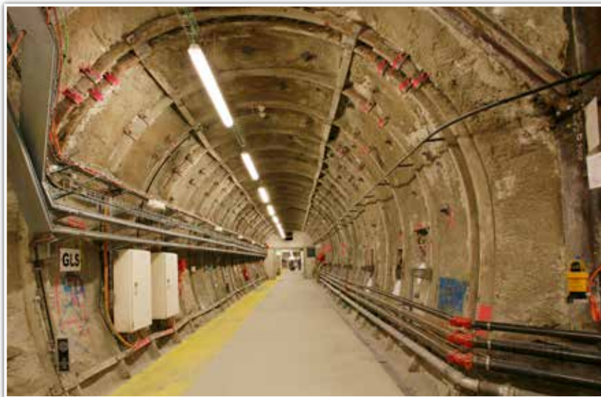
► Galerie du Laboratoire souterrain
